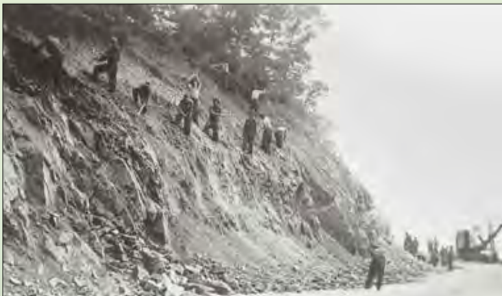
Trabajadores de CCC construyen controles de la erosión a lo largo de Skyline Drive. NPS / ABAQ—NPS / ED KNEPLEY
