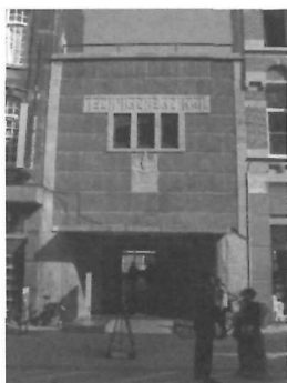
FIGURE 7 Tweebronnen, Street Façade.
