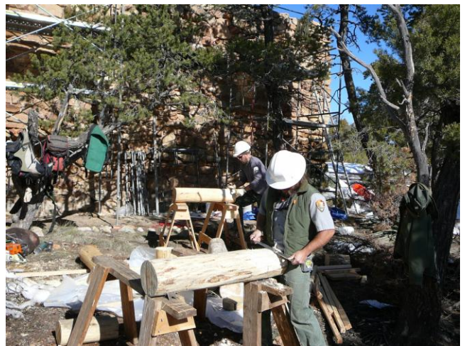
Shaping viga ends
