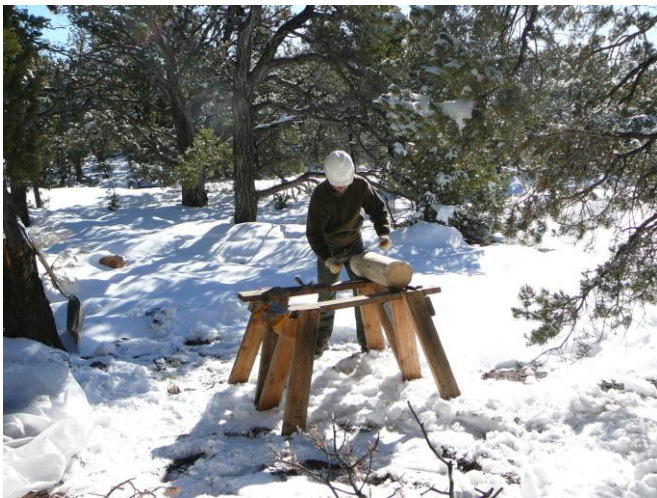
Shaping viga ends
