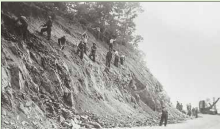
CCC-Arbeiter legen Erosionsschutz entlang dem Skyline Drive an. NPS, KUNZ/NPS, ED KNEPLEY
